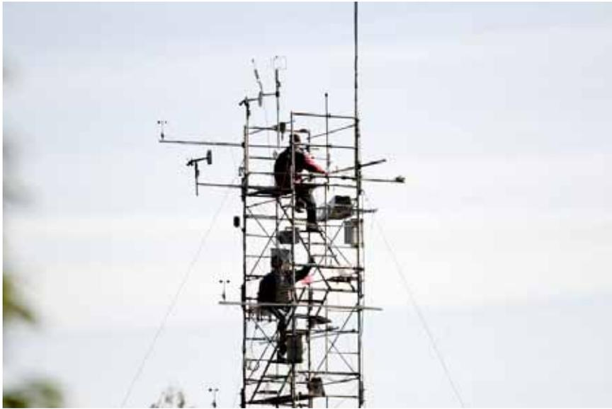
圖 2 氣象塔近攝圖，此處為氣象塔穿過冠層頂端部分，氣象塔外側為各種氣象儀器。
